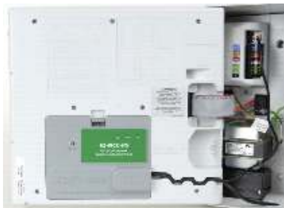
Cartouche de communication IQ (installée)
