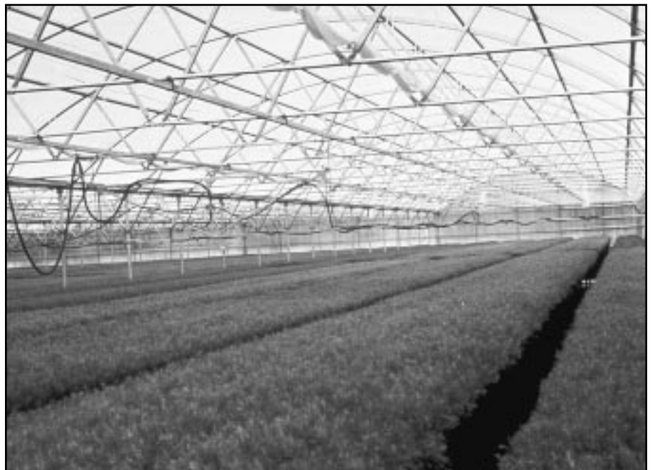
Aplicación en un invernadero con muchos ciclos cortos de encendido durante la "ventana" de irrigación.
