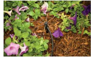
Conecte un emisor con púas (en una estaca) a una tubería con emisor con un conector estriado y una tubería de 6 mm
