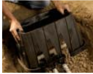
Knock-out está diseñado para acoplarse a la mayoría de las configuraciones de tuberías
